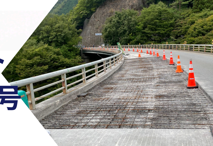
▲ WJはつり施工現場・芦川大橋（山梨県）
