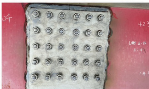
▲ レーザー施工後（30分照射後の状態）
