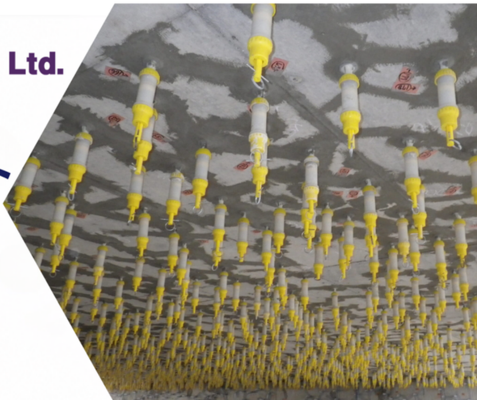
▲ リハビリシリンダー工法・施工の様子
