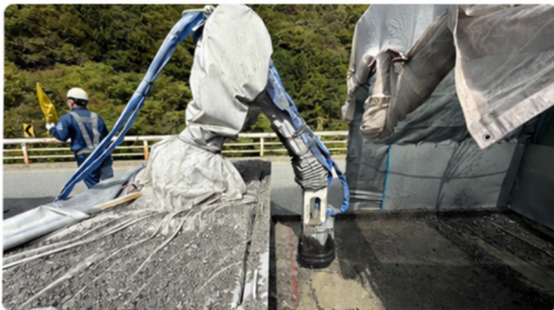
▲ WJロボットアーム式工法・施工の様子
